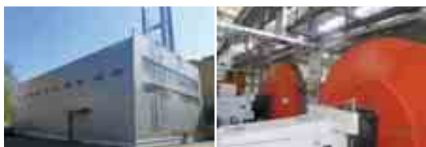
г. Санкт-Петербург, ул. Черняховского, д. 7, лит. В (установленная мощность объекта — 23,94 МВт). Использованы водогрейные котлы GKS Dynatherm 5000 компании Wolf (стр. 171)
