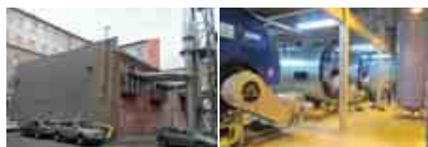
г. Санкт-Петербург, наб. р. Мойки, д. 5, корп. 2, лит. Б (установленная мощность объекта — 22 МВт)
