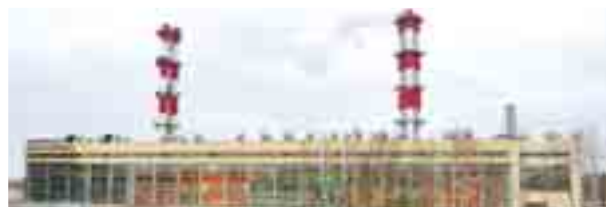
г. Ломоносов, ул. Федюнинского, д. 3а, лит. А, Е, Д, К, И (установленная мощность объекта – 319,4 МВт). Использован водогрейный котел Eurotherm 58 компании Wolf (стр. 171)
